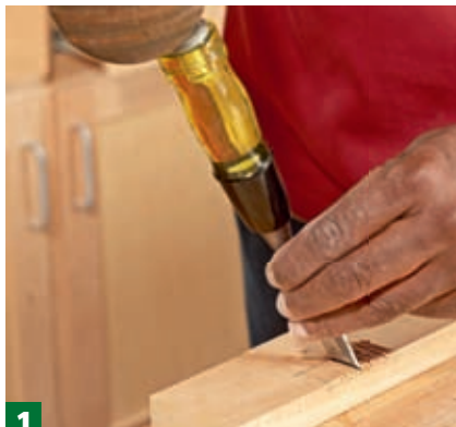
1 Слегка наклонив стамеску, сделайте ряд неглубоких зарубок, не доходя 1,5-2,0 мм до линий разметки.
