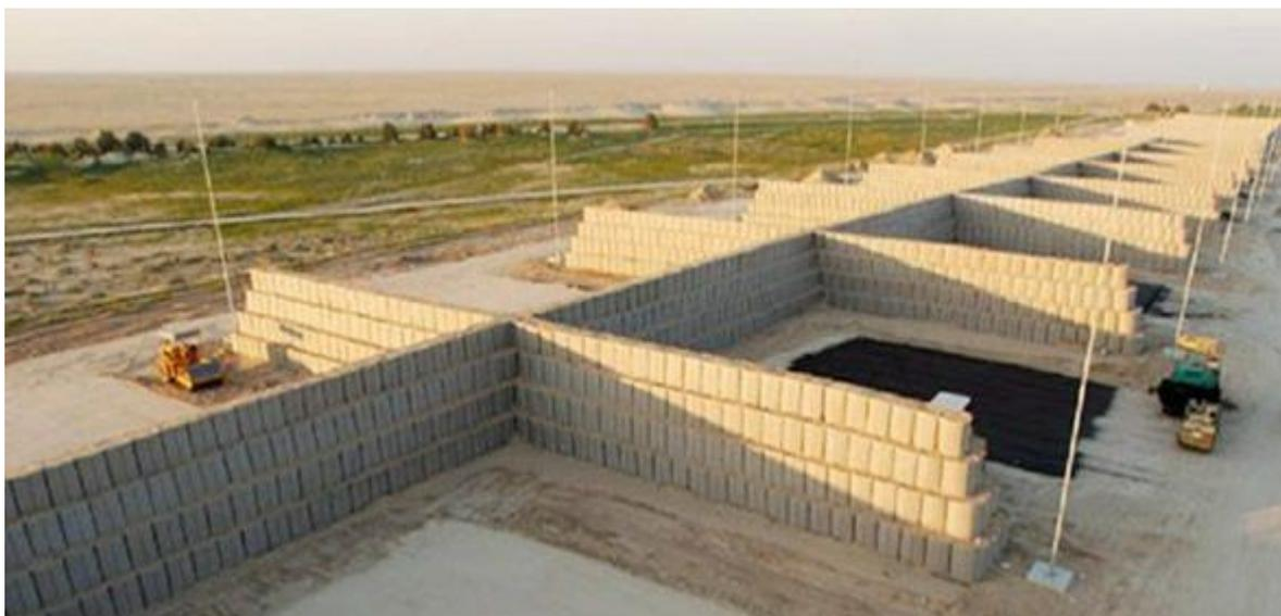
Рис.1 Вариант установки габионов насыпного типа
