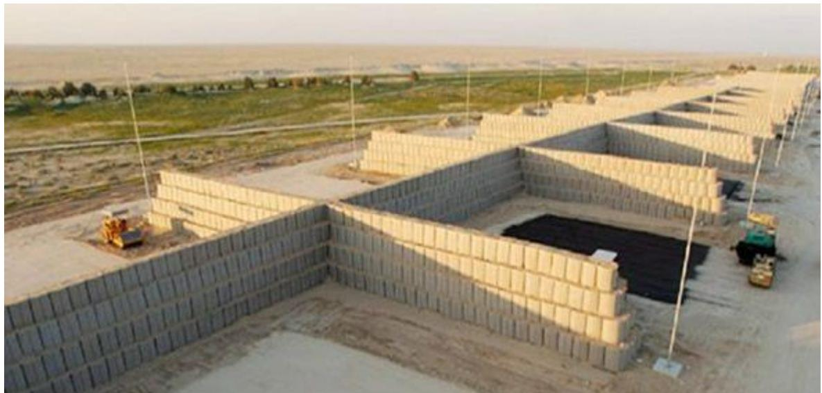
Рис.1 Вариант установки габионов насыпного типа
